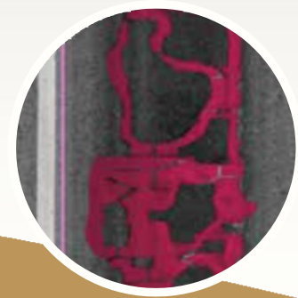
密封補修されている ひび割れ
